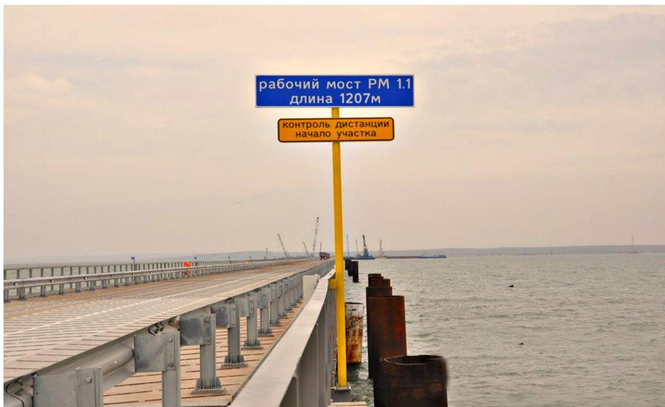
В Керченском проливе продолжается интенсивная подготовка к началу строительства моста, который соединит Крым с материковой Россией: ведется создание второго и третьего рабочих мостов – временных сооружений, необходимых для строительства основного моста. Первый рабочий мост соединил таманский берег и остров Тузла в октябре 2015 года и активно используется, позволяя минимизировать влияние на стройку погодных условий – особенно в период зимних и весенних штормов.
